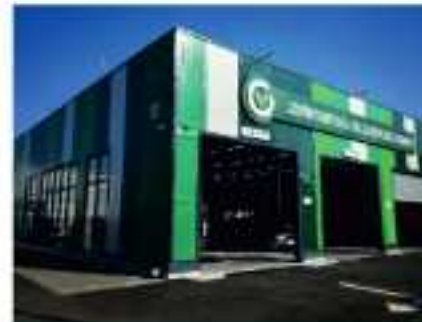
ЦЕНТРЫ ТЕХОСМОТРА GREENWAY УСТРОЙСТВО НАПОЛЬНЫХ ПОКРЫТИЙ ПОЛНОГО ЦИКЛА г. Тбилиси
