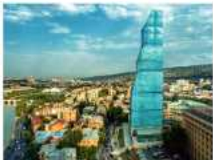
THE BILTMORE HOTEL УСТРОЙСТВО АВТОПАРКОВКИ, СТЯЖКА ПОЛА, г. Тбилиси
