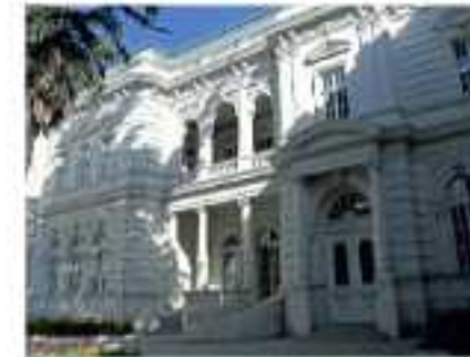
РЕЗИДЕНЦИЯ ПРЕЗИДЕНТА УСТРОЙСТВО БЕТОННОГО ПОКРЫТИЯ г. Тбилиси
