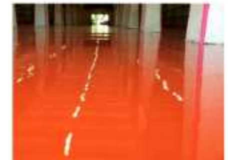
ВИННЫЙ ЗАВОД WINE MAN РЕСТАВРАЦИЯ ПОЛА, УКЛАДКА ПОЛИМЕРНОГО ПОКРЫТИЯ г. Тбилиси
