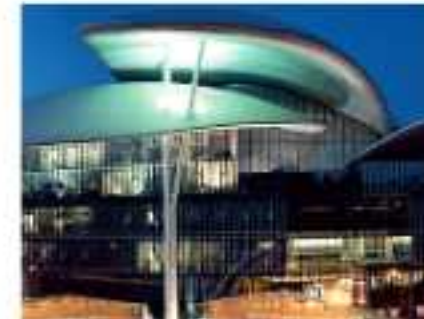
ДОМ ЮСТИЦИИ ГРУЗИИ УСТРОЙСТВО БЕТОННОГО ПОКРЫТИЯ г. Тбилиси
