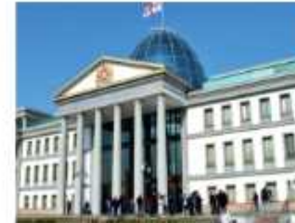
ПРЕЗИДЕНТСКИЙ ДВОРЕЦ УСТРОЙСТВО БЕТОННОГО ПОКРЫТИЯ г. Тбилиси
