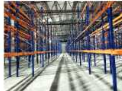
ЛОГИСТИЧЕСКИЙ КОМПЛЕКС GRAND PHARM. УСТРОЙСТВО ТОПЛИНГОВЫХ БЕТОННЫХ ПОЛОВ г. Ташкент
