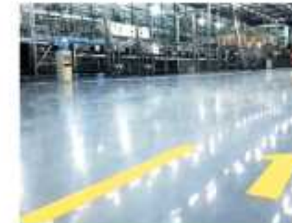
IDS BORJOMI INTERNATIONAL УСТРОЙСТВО БЕТОННЫХ И ПОЛИМЕРНЫХ ПОКРЫТИЙ ПОЛА г. Боржоми
