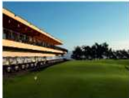
ГОЛЬФ КЛУБ TBILISI HILLS. ГИДРОИЗОЛЯЦИОННЫЕ РАБОТЫ г. Тбилиси
