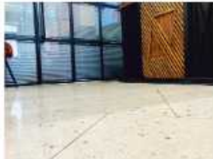
ОФИС BELTERA HOLDING УСТРОЙСТВО ПОКРЫТИЯ TERRAZZO. ПОЛИРОВАННОГО БЕТОННОГО ПОЛА г. Ташкент
