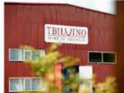
ВИНОДЕЛЬНЯ TBILVINO УСТРОЙСТВО БЕТОННОГО ПОЛА г. Тбилиси
