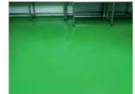
ФАБРИКА FOODMART УСТРОЙСТВО ПОЛИМЕРНОГО ПОКРЫТИЯ ПОЛА г. Тбилиси
