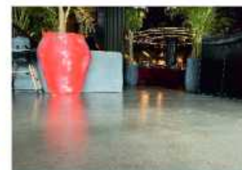
УСТРОЙСТВО ПОЛИРОВАННОГО БЕТОННОГО ПОЛА
