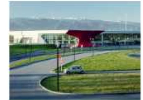
АЭРОПОРТ КУТАИСИ УСТРОЙСТВО БЕТОННОГО ПОКРЫТИЯ г. Кутаиси
