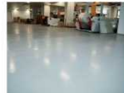
ФАБРИКА УПАКОВКИ GEORGIAN PACKAGING УСТРОЙСТВО ПОЛИРОВАННОГО БЕТОННОГО ПОКРЫТИЯ ПОЛА г. Тбилиси
