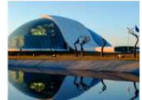
ПАРЛАМЕНТ ГРУЗИИ УСТРОЙСТВО БЕТОННОГО ПОКРЫТИЯ г. Кутаиси
