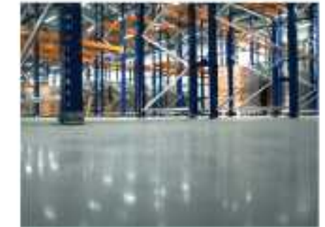
ДИСТРИБУЦИОННАЯ КОМПАНИЯ MASTER TRADE УСТРОЙСТВО БЕТОННОГО ПОКРЫТИЯ г. Кутаиси
